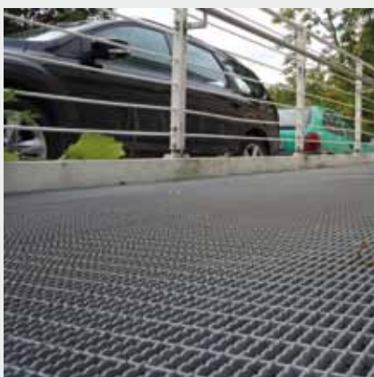
Dieser feinmaschige Gitterrost einer Außenrampe ist auch für Personen mit Gehhilfen geeignet
