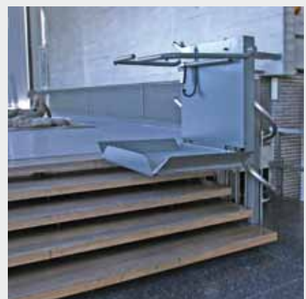
In Bestandsgebäuden kann der Einbau eines Plattformliftes sinnvoll sein, wenn die Treppe ausreichend breit ist
