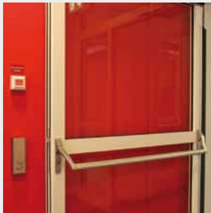
Der Öffnungstaster links neben der Automattür sollte in einem Mindestabstand von 2,50 m vor der Tür angeordnet werden
