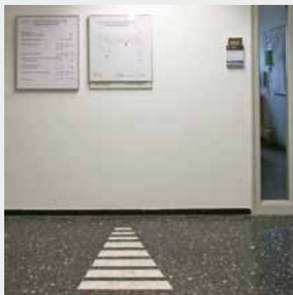
Die Bodenkenzeichnung weist auf Etageninformationen hin, die zusätzlich in Brailleschrift und erhabener Profilschrift ausgeführt sind
