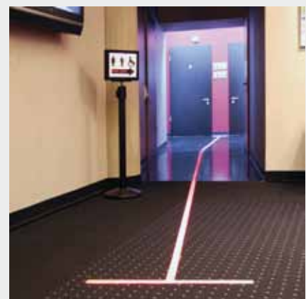
Eine taktile Leitlinie aus Acrylglas, die mit Hilfe von Leuchtdioden von unten beleuchtet wird, führt zu den Toiletten an
