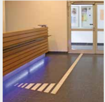
Ein kontrastreicher und taktiler Bodenindikator leitet Besucher vom Gebäudezugang zum Empfang
