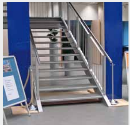
Treppen ohne Setzstufen bergen Unfallrisiken für Menschen mit Geh- und Sehbehinderungen
