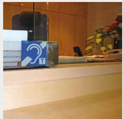
Der Empfangsbereich ist mit einer Induk-tionsschleife ausgestattet
