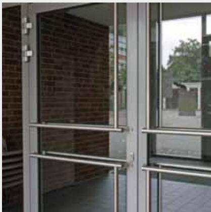
Die Türgriffe verlaufen über die gesamte Tür und können so von Menschen mit unterschiedlicher Größe genutzt werden
