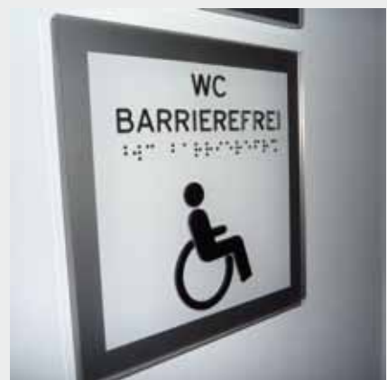
Das tastbare WC-Schild sollte neben der Tür auf der Seite des Türdrückers in 145 cm bis 165 cm Höhe angeordnet werden
