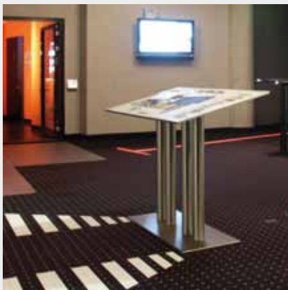
Der tastbare Übersichtsplan an zentraler Stelle ist durch kontrastreiche und taktile Bodenindikatoren auffindbar
