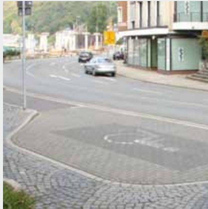
Der Behindertenparkplatz ist schwellenfrei an den Bürgersteig angebunden, doch das Kleinpflaster ist nicht erschütterungsarm befahrbar
