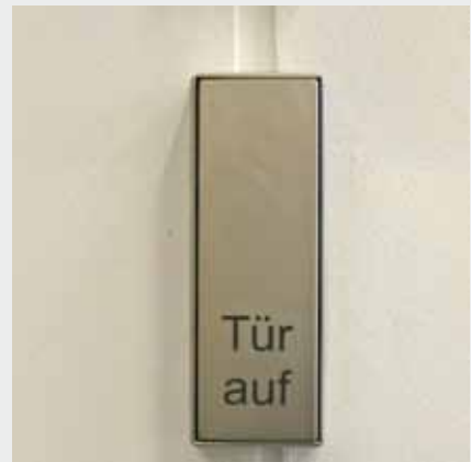
Ein großflächiger Öffnungstaster ist für Menschen mit eingeschränkter Motorik gut zu bedienen
