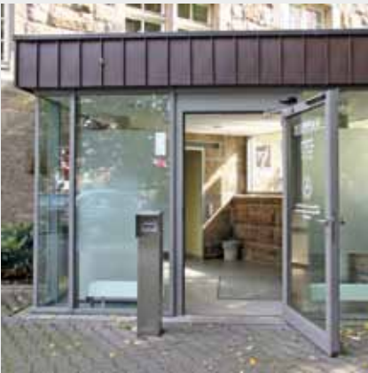
Da der Haupteingang nicht barrierefrei umzugestalten war, wurde ein neuer barrierefreier Seiteneingang geschaffen
