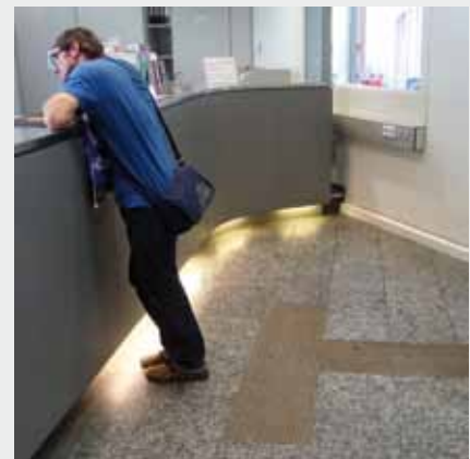
Die Anforderung an eine kontrastreiche Ausführung des Leitstreifens wurde hingegen nicht berücksichtigt
