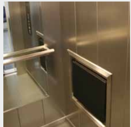
Der Spiegel zeigt an, ob beim Rückwärtsfahren Hindernisse im Wege stehen. Der Klappsitz dient Menschen mit Gehbehinderung als Sitzgelegenheit
