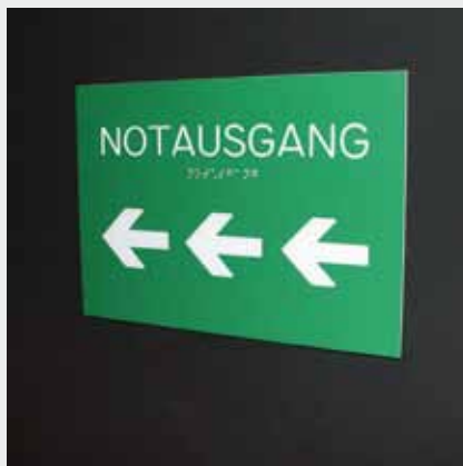
Das Notausgangsschild mit taktilen Symbolen, erhabener Profilschrift und Brailleschrift ist auch für blinde Menschen lesbar
