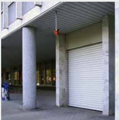
Die Blitzleuchte an einer Tiefgaragenausfahrt warnt Vorbeigehende optisch und akustisch vor querenden Autos
