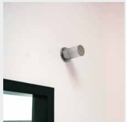
Die Blitzleuchte im Sanitärraum dient im Evakuierungsfall als optischer Alarm für Menschen mit Hörbeeinträchtigungen
