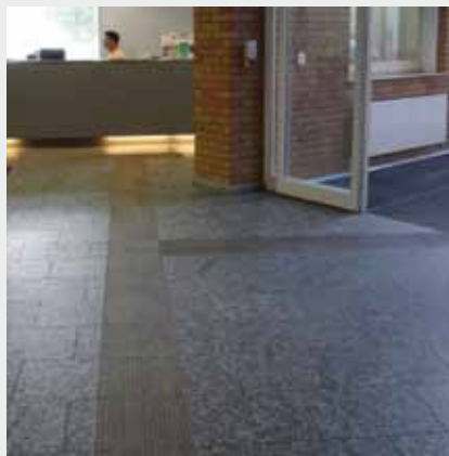
Ein Leitstreifen aus taktilen Rillenplatten führt vom Eingang zu den Aufzügen und zum Empfangstresen
