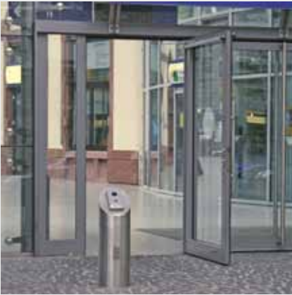
Die kraftbetätigte Tür lässt sich sensor-gesteuert öffnen; der Türöffner befindet sich in ausreichendem Abstand zur Tür
