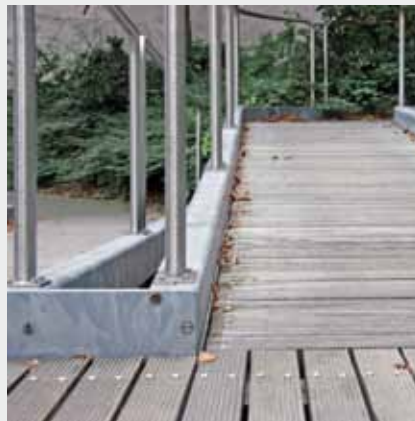
Ein Radabweiser mit rechteckigem Profil ist durchgängig auf beiden Seiten der Rampe vorhanden
