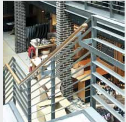
Der Handlauf ist entsprechend DIN 18040 in 85 cm Höhe auf der Innenseite des Geländers angebracht, die Brüstung selber ist höher
