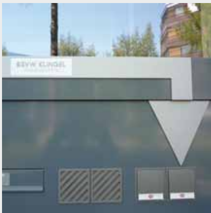
Ein kontrastreicher und taktile Hinweis-pfeil mit einem tastbaren Schild führen zum Klingeltaster
