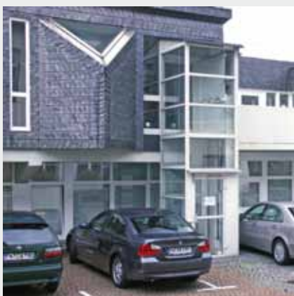
Dieser Außenaufzug wurde als Hub-plattform in einem gläsernen Schacht nachträglich angebaut
