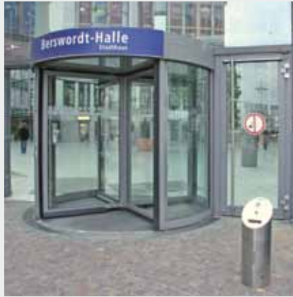
Zusätzlich zur Karusselltür stehen seitlich zwei Automattüren zur Verfügung
