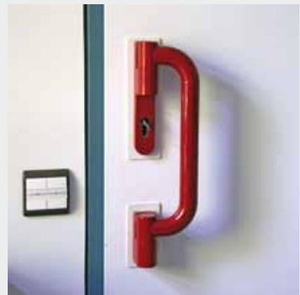
Durch Pressen des Türgriffs kann die Tür auch ohne Greifen entriegelt und geöffnet werden
