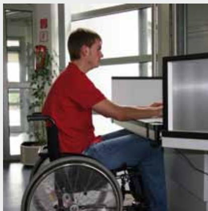
Der kontrastreich gestaltete Tresen ist in einem Teilbereich abgesenkt und unterfahrbar
