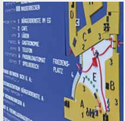
Der Übersichtsplan ist durch erhabene Elemente und taktile Beschriftung für blinde Menschen tastbar
