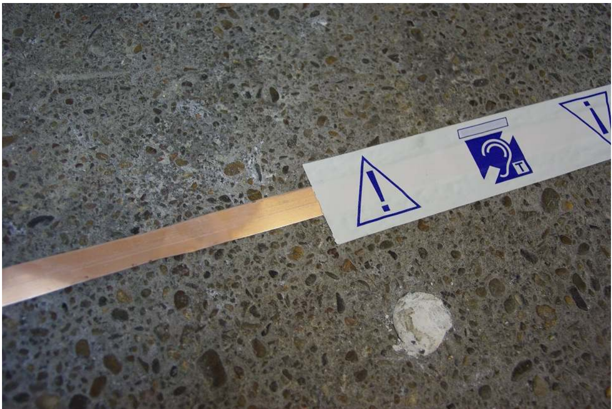
Abbildung 14 : Beispiel für die Verklebung einer Kupferschleife mittels eines Spezialklebandes
