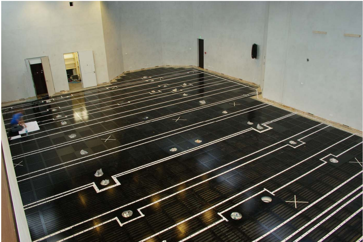
Abbildung 13 : Beispiel für die Verlegung eines Low – Spill – Over – Systems auf einem Metallboden
